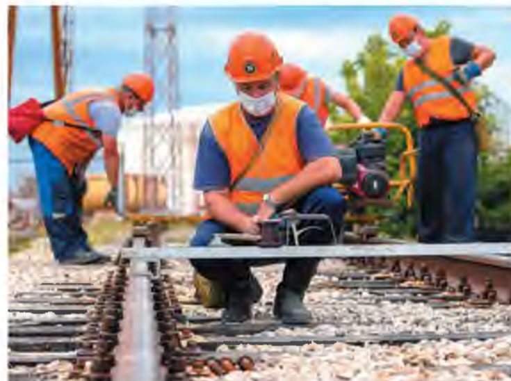
Рельсы нуждаются в уходе: железнодорожники их рихтуют и выправляют
