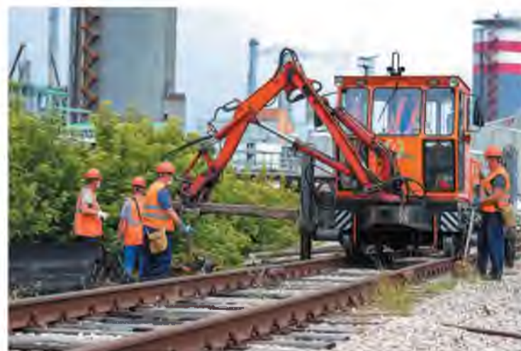
А вот и рельсоукладчик подъехал
