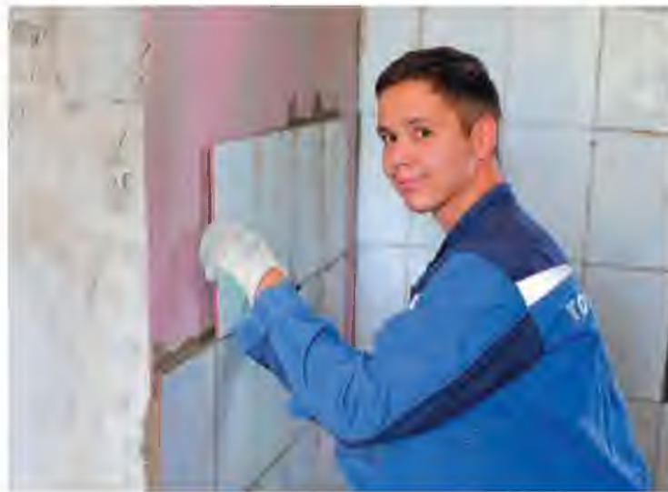
Дамир Зайдулин – облицовщик-плиточник из цеха №119: «Одеваем стены в керамическую одежду»
